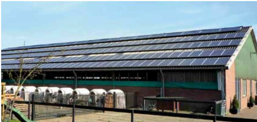
Vijftien melkveehouders op het Kampereiland wekken duurzame energie op door het monteren van zonnepanelen op hun melkveestallen.
